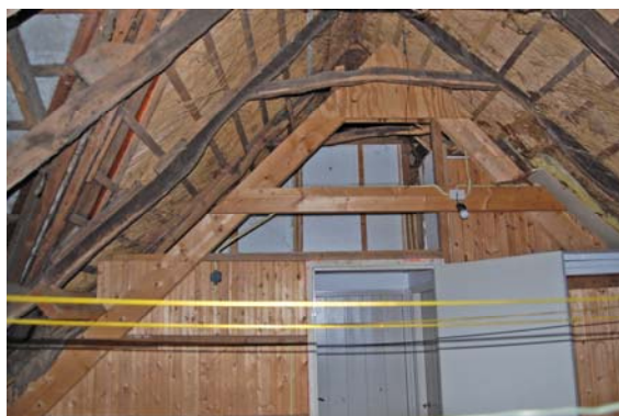
In de kap geplaatst spant ten behoeve van de in 1991 aangebrachte gordingen.
