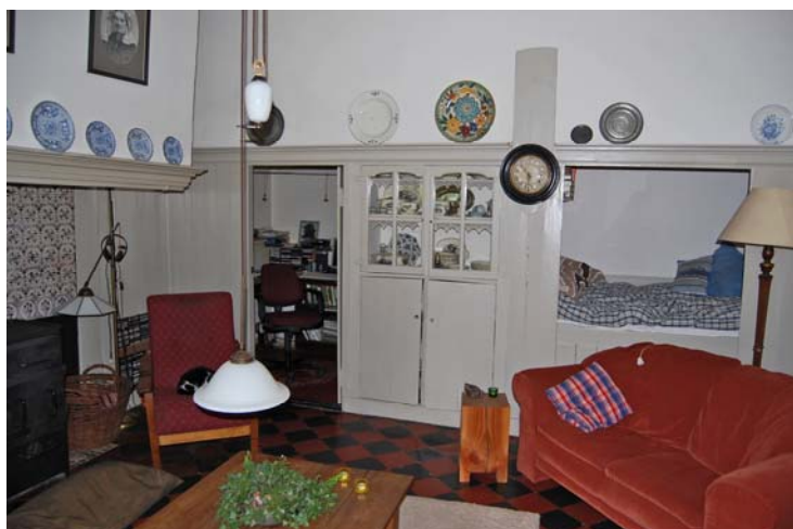
Overzicht van het woonvertrek van de rechter woning met tegen de achterzijde een bedstedenwand met tussen de bedsteden een servieskast met een karakteristieke 18 de eeuwse geprofileerde bovendorpel.
