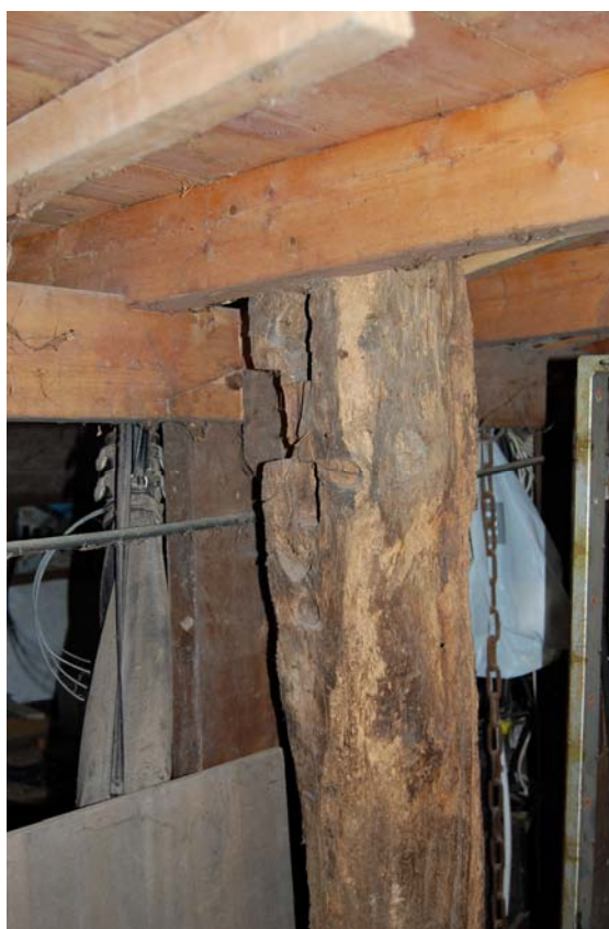
Eén van de gebintstijlen ter hoogte van de pengaten van de verdwenen steekrijen.
